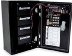
Un pico transitorio es un aumento repentino del valor de voltaje en línea. Un supresor se encarga de conducir a través de un adecuado sistema de tierra, aquellos picos transitorios (de corta duración) que son generados por arranque de maquinaria, cortocircuitos, tormentas eléctricas, etc.
